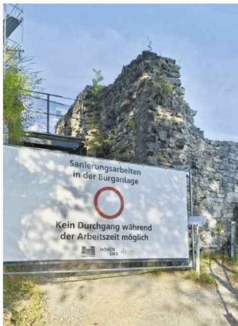
Die Burgruine Alt-Ems ist bis Ende August wegen Sanierungsmaßnahmen teilweise gesperrt (Foto: Winkler)
